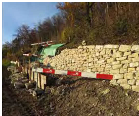
Aufwändige Sanierung der Trockenmauern entlang des historischen Verkehrswegs in Schinznach.
