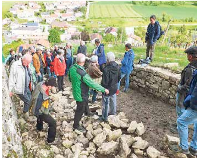
Instandstellung von Trockenmauern: ein Gewinn für Natur und Landschaftsbild, hier am Beispiel Chalm in Schinznach-Dorf Bild: Hans Lenzi
