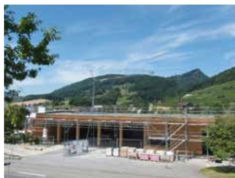
Aktuelles Projekt auf dem Dach des neuen Feuerwehr- und Werkhofgebäudes.
