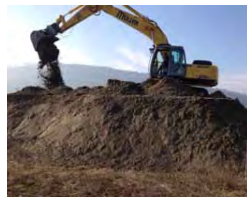
Ueli Müller, Stetten AG, beim Aufbauen des Uferschwalben-Sandwalls. Foto Françoise Schmit
