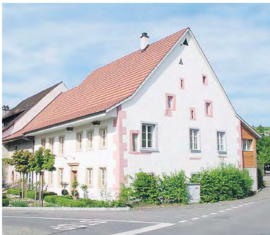
Mustergültig renoviertes «Schaffner-Haus»
