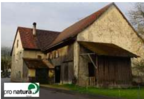
Das «Flederhaus» an der Hauptstrasse in Wegenstetten, noch vor der Renovation.
